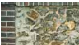
Maçonnerie de brique et silex.
