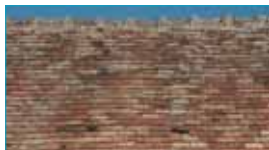
Le faitage des toitures en tuile.
