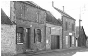
Avant : baie dénaturée (partiellement remplie en parpaings).
