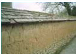
Mur en terre crue, soubassement silex. Broué.
