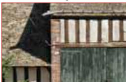
Colombages protégés par un lait de chaux.
