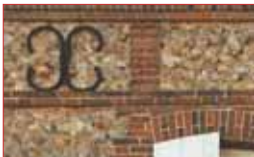
Maçonnerie de brique et silex.
