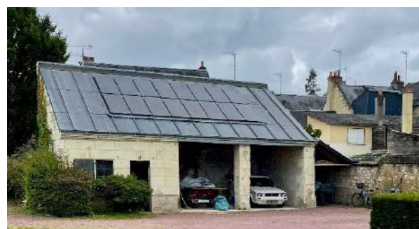
Panneaux photovoltaïques intégrés dans une couverture en zinc. Le rythme des panneaux et des joints à tasseaux du zinc coïncident parfaitement. Les panneaux sont encastrés dans la couverture ce qui contribue à les rendre très discrets. Bourgueil (37)
